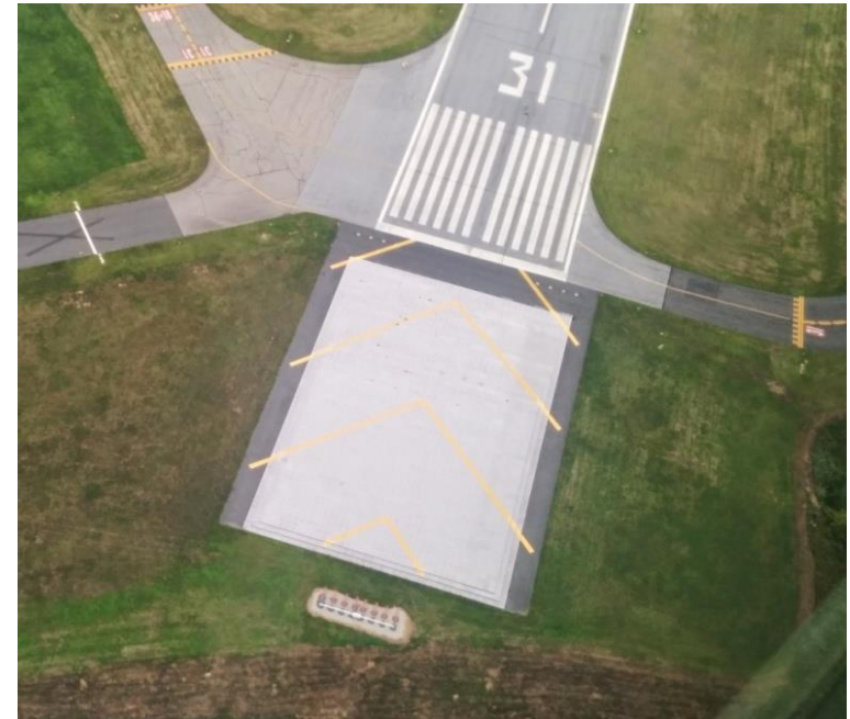
Площадка системы аварийного торможения самолетов в аэропорту Ридинг в штате Пенсильвания, установленная в 2009 году
