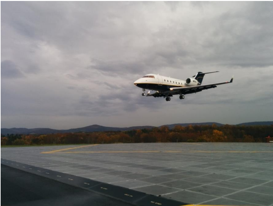
Площадка системы аварийного торможения самолетов в аэропорту Ридинг в штате Пенсильвания, установленная в 2009 году
